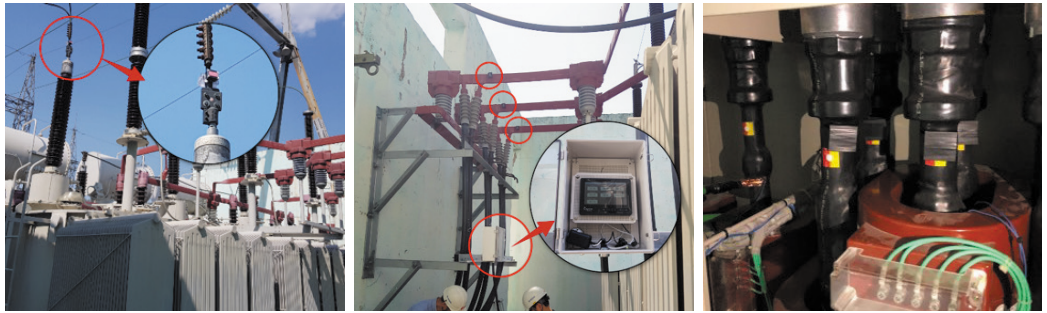
한전 진주 변전소 - 154KV 변압기부싱, 인입부 부스바, 무인변전소 전력선
